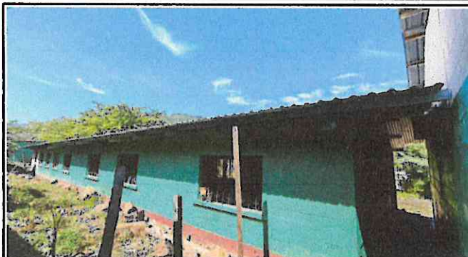
Foto 1: Sustrucción de canal de metal sujeto con perfiles de metal a cada 60 cm
